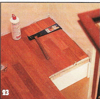
23 Между покрытием пола площадки и стенами оставляют зазоры, которые потом укроют плинтусами.
